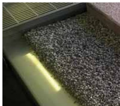
Aanbrengen van split/mastiek en aanbrengen van de eindafwerking.
