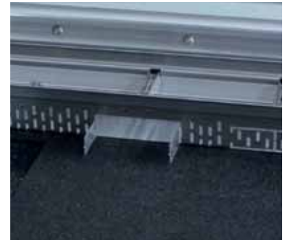
Openen van de aansluiting t.b.v. het aansluiten van de zijgoten/steunen.
