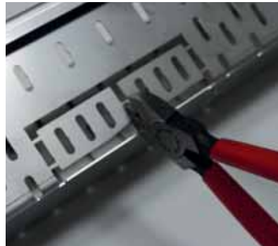
Het openknippen van de zijaansluitingen.
